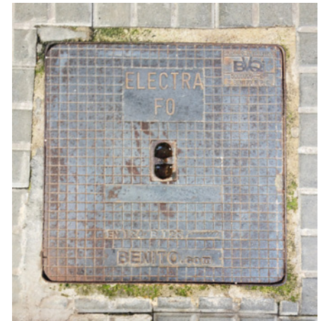
ARQUETA D'OBRA PÚBLICA
